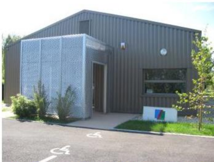
Les nouveaux bureaux de l'agence d'exploitation de Saint Rémy
