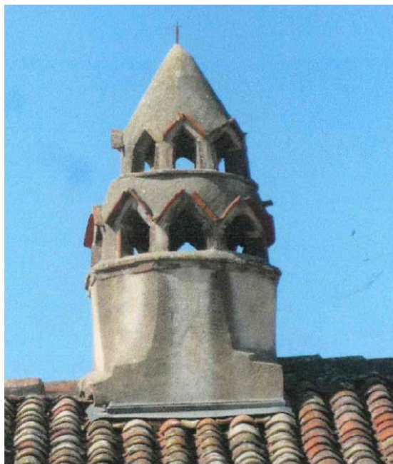
Saint-Didier d'Aussiat , Cheminée avec sa mitre de la ferme de Cossiat (source : UDAP Ain)
